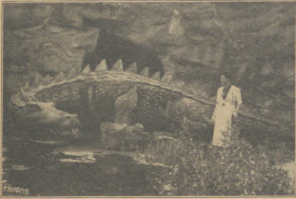
Der Drachen vor der Höhle an der Wagner-Gedächtnishalle
