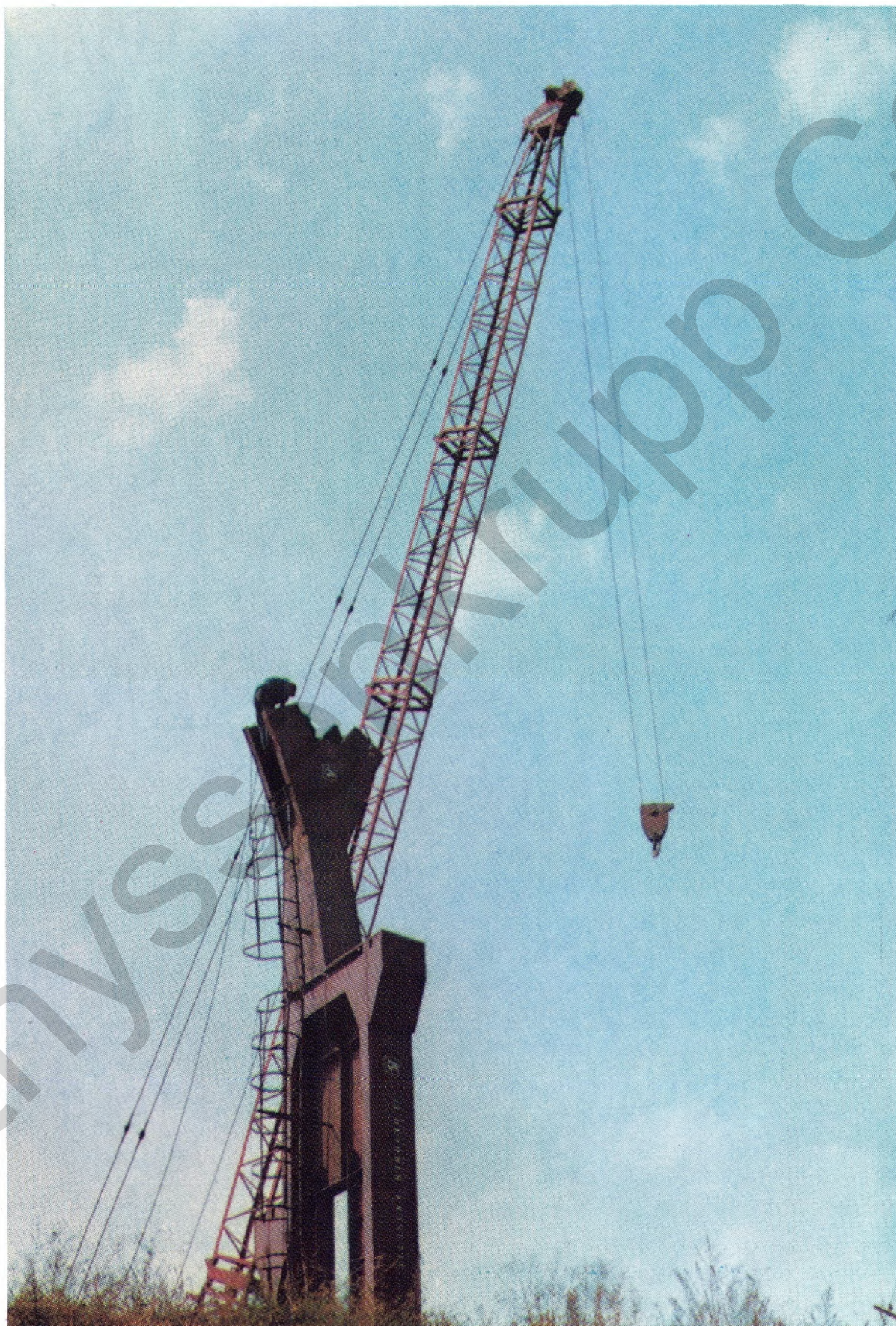
310 Hektar „grüne Wiese“ standen für den Bau des Stahlwerks zur Verfügung. Und wie auf diesem Bild, so wächst jetzt die Halle des Warmwalzwerks regelrecht aus der Wiese
