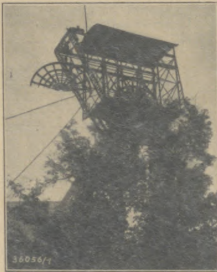
Auf Schacht Heinrich wird eine neue Seilscheibe eingebaut
