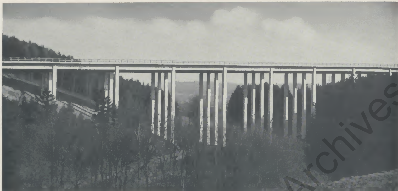
Die auf 36 Eisenbeton-Säulen ruhende 30 m hohe Brücke über das Tal des Helderbaches bei Melsungen
