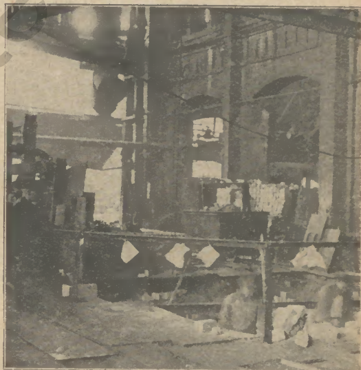
Bild 4: Deutliche Kennzeichnung einer Baugrube durch angehängte Papierstreifen (nur in bedecktem Raum zu empfehlen, da im Freien durch Witterungseinflüsse bald beschädigt)
