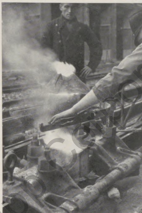
Zurückschwenken des Tiegels nach dem Einguß
