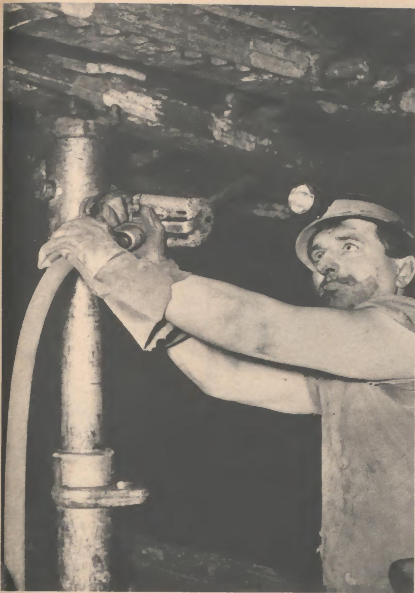
▲ Nach dem Aushobeln eines Feldes beginnt das Einbringen des Strebausbaus. Dabei werden die Stempel hydraulisch gesetzt und verspannt. Auf unserem Bilde ist Hauer Radmacher dabei, einen solchen Stempel zu setzen
