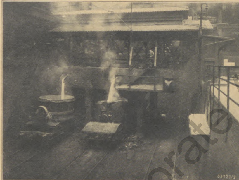
Füllung der Roheisen-Pfanne (rechts) beim Abstich
