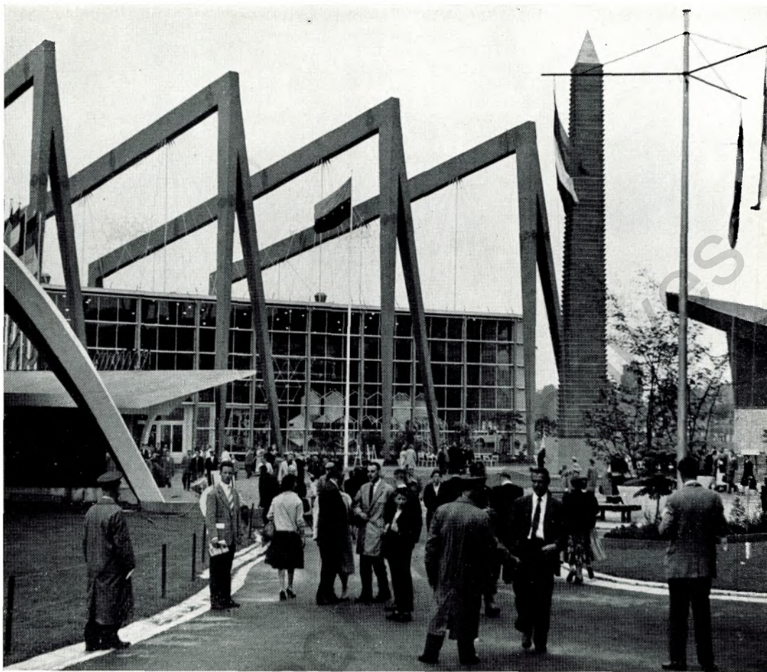
DAS HAUS DER MONTANUNION auf der Brüsseler Weltausstellung ist einer der kühnsten Einfälle der Architekten, mit Stahl und Glas zu bauen; Das ganze Haus hängt mit dicken Stahlseilen an schweren Stahlträgern
