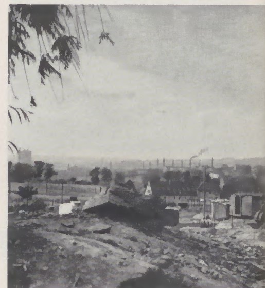
Die Erdarbeiten haben begonnen: Blick vom Wohnungsbauprojekt „Brandtstraße“ auf die Hütte
