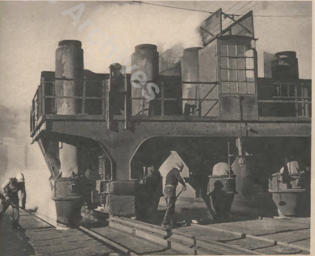
▼ Auf der Kokerel Kaiserstuhl, die auch nach der Stilllegung des Grubenbetriebes weiterarbeitet, ein Blick auf den Ofenwagen, der die Batterien mit Kokskohle beschickt
