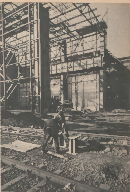
▲ Ein anderes Beispiel für das Wachsen der Breitbandstraße: noch im Bau ist die Erweiterung der Stripperhalle
