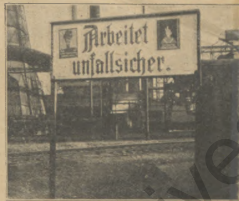
Auf dem Wege zum Hochofen u. Maschinenbetrieb. Eine Unfallschrift, unter der jeder Arbeiter hindurchgehen muß, die so nicht übersehen werden kann.
