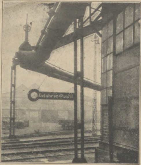
„Gefahrenpunkt.“ Ein Signalarm warnt vor der Gefahr beim Ueberschreiten der Gleise.
