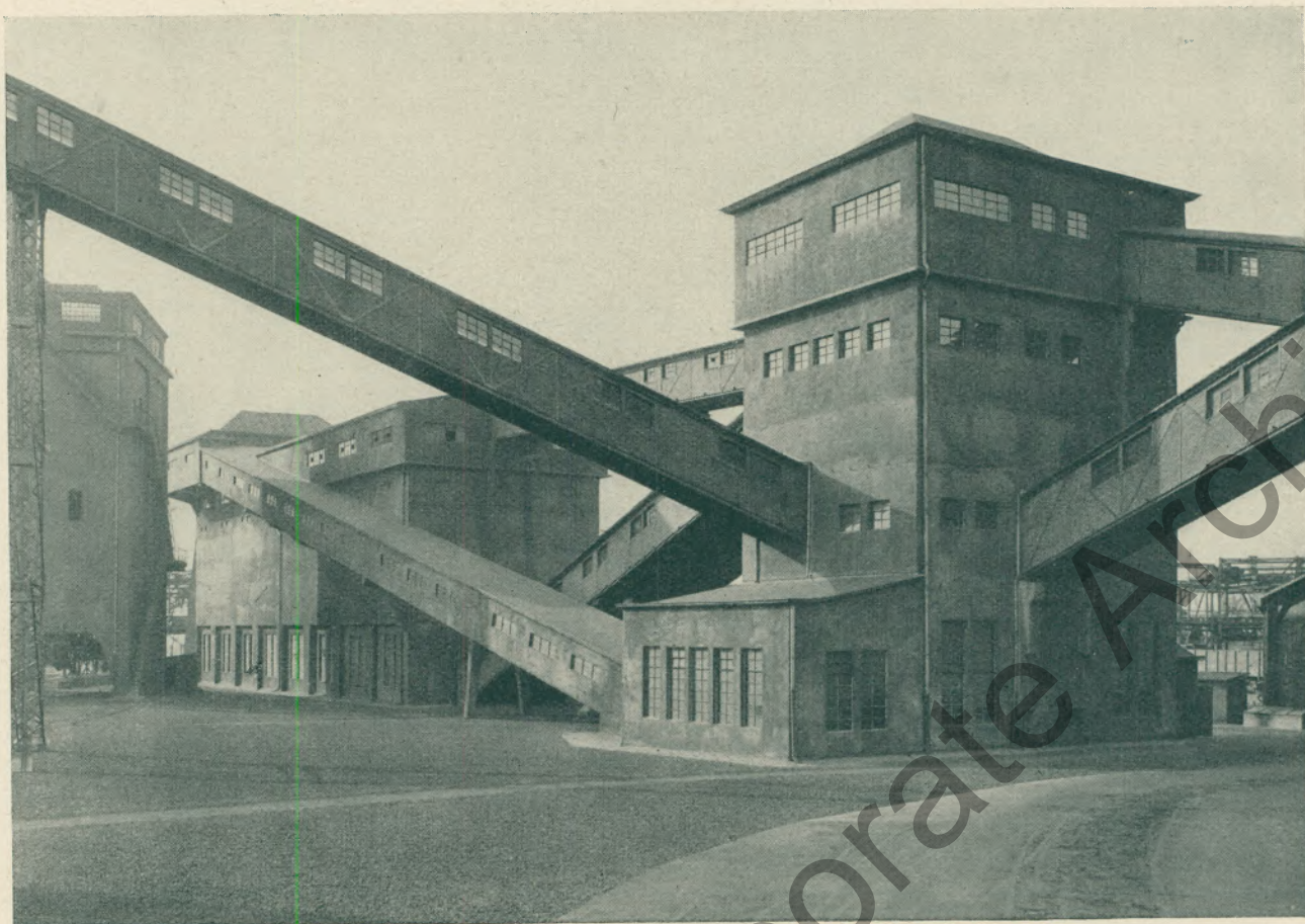
Rohkohlens-Mischanlage der Beche Karolinenglück. (Vereinigte Stahlwerke Aktiengesellschaft.)
