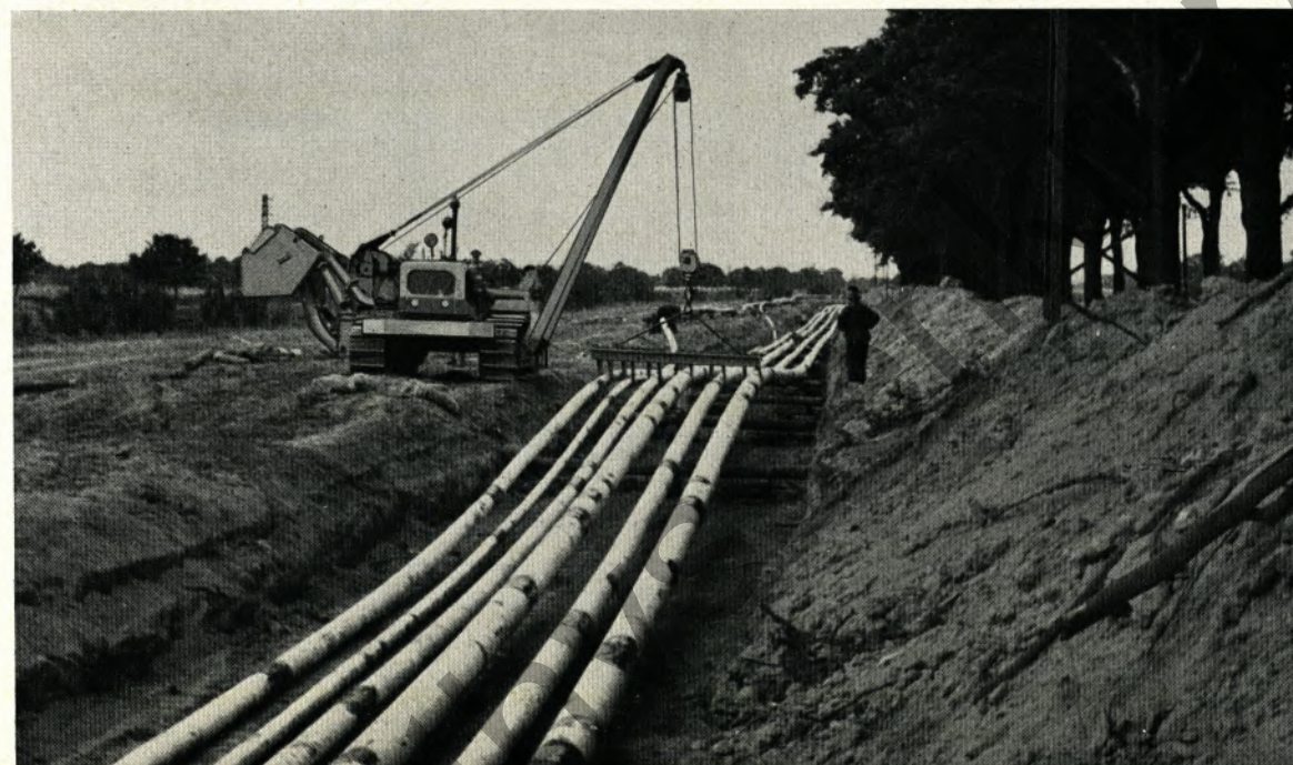
Die Tankerlöschbrücke in Wilhelmshaven ist der Ausgangspunkt der Nord West-Ölleitung, durch die das Rohöl zur Raffinerie gepumpt wird. — Bild unten: Mit diesem modernen Seitenbaumtraktor wurden die sechs Leitungen zum Hafen verlegt. — Rechts: Eine den Laien verwirrende Vielfalt bilden die Filter und Durchflußmesser auf den beiden Verladebrücken im neuen Rhein-Lippe-Hafen bei Wesel
