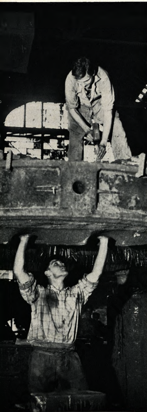
Oben: Vorbereitung des Oberkastens eines Sternrades vor dem Zusammensetzen der Gußform. — Oben rechts: Das Riesenzahnrad hat ein Fertiggewicht von ca. 14 t und ist für eine Zuckermühle in Argentinien bestimmt. Vor dem Abtransport überprüfen zwei Arbeiter noch einmal das Werkstück, das fast so groß ist wie das Hallentor. — Darunter: Der Leiter der Verkaufsabteilung, Riefkogel, berichtet der Geschäftsführung über die Absatzlage
