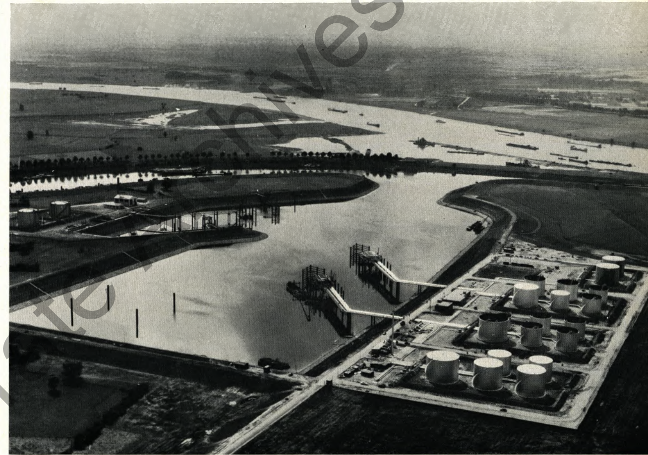
Eine Luftaufnahme des Rhein-Lippe-Hafens, in dem 50 Prozent der Fertigprodukte umgeschlagen werden. Deutlich erkennt man das Tanklager und die Verladebrücken. Die gesamte Rohrverlegung und die Installation der Meßeinrichtungen führte der VRB aus
