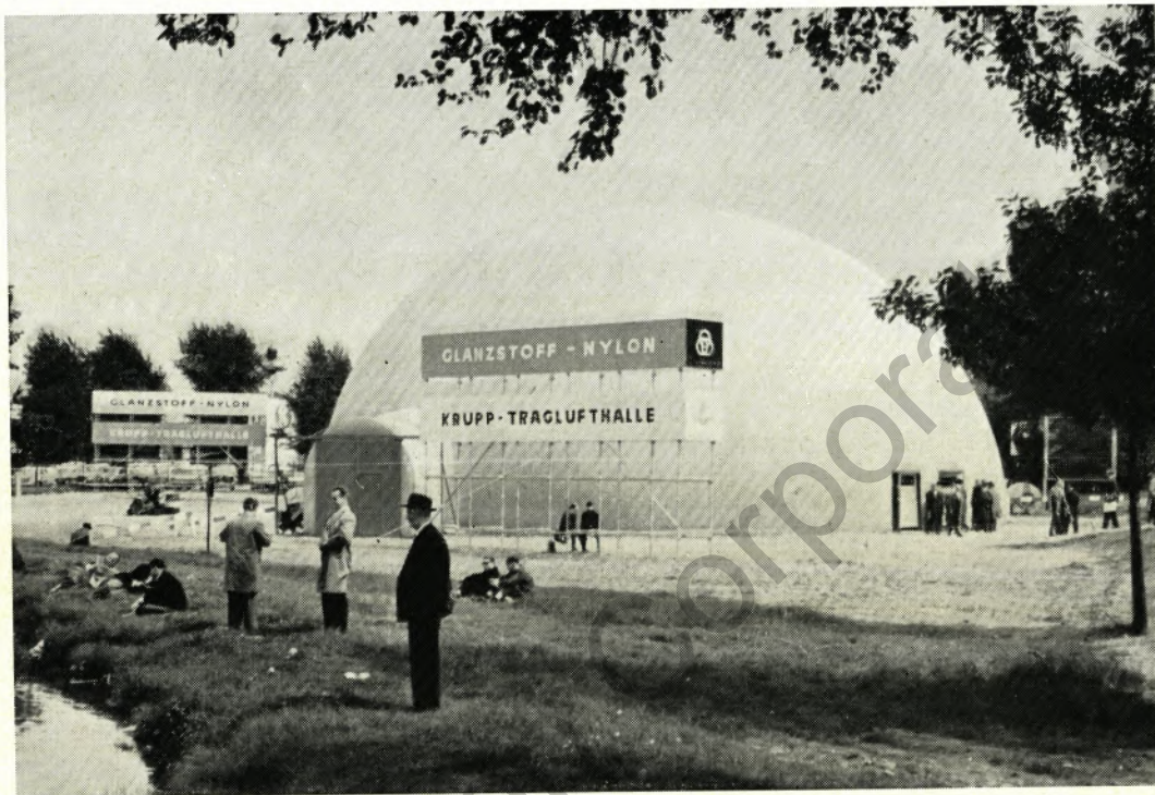
Durch eine solche gasbeheizte Traglufthalle ist Bauen nun auch im Winter möglich.
