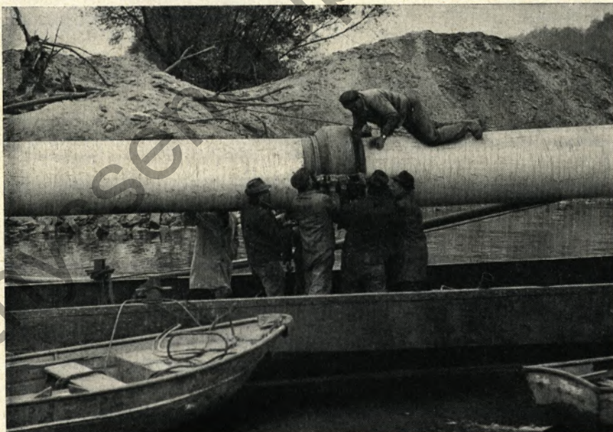
Vater Rhein sorgt in der hessischen Landeshauptstadt Wiesbaden in Zukunft für „Nachschub“ an Trinkwasser. Aus unseren ZM-Stahlrohren wurde ein 380 m langer Rohwasser-Entnahmedüker in den Rhein abgesenkt. S. 12/13
