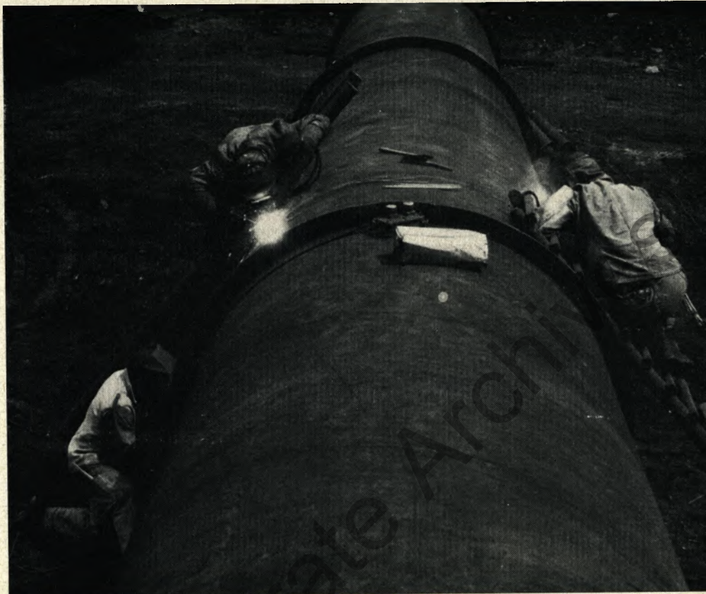
Schweißer bereiten die fast zwei Meter dicken Rohre für den Einbau in die Leitung vor.
