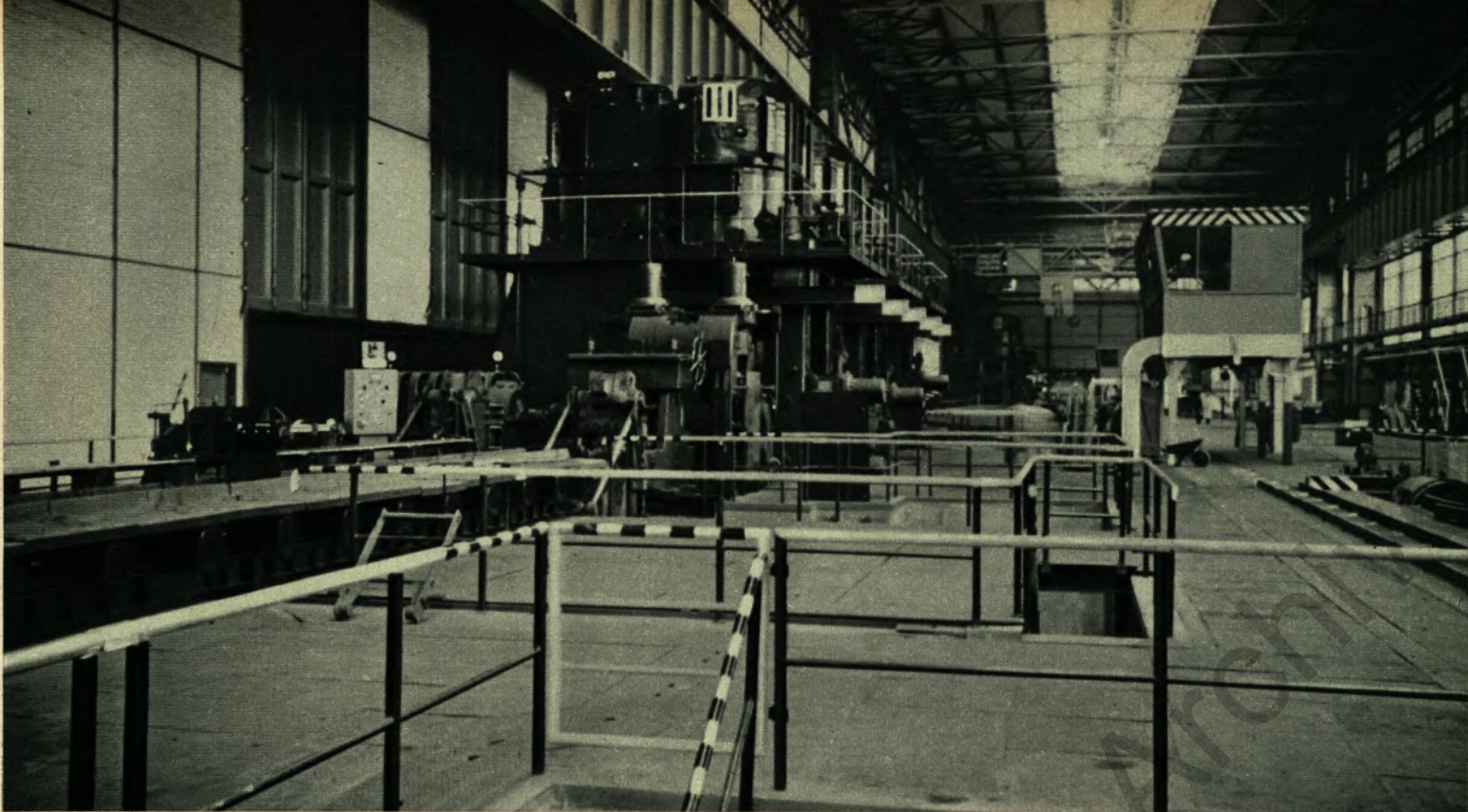
Die neue Halbzeugstraße der Westfalenhütte, die am 31. März 1955 in Betrieb genommen wurde
