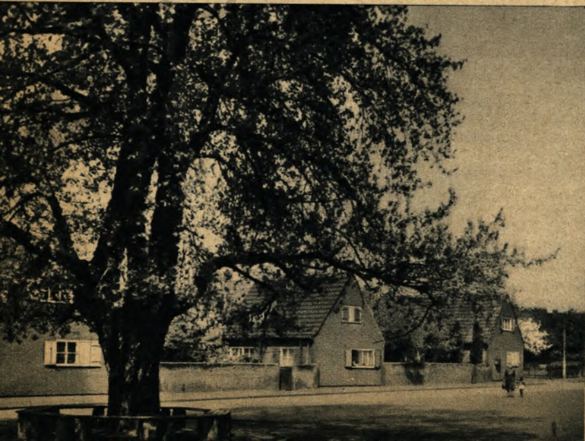
Siedlungshäuser in der Springorum-Siedlung Dortmund-Kirchderne
