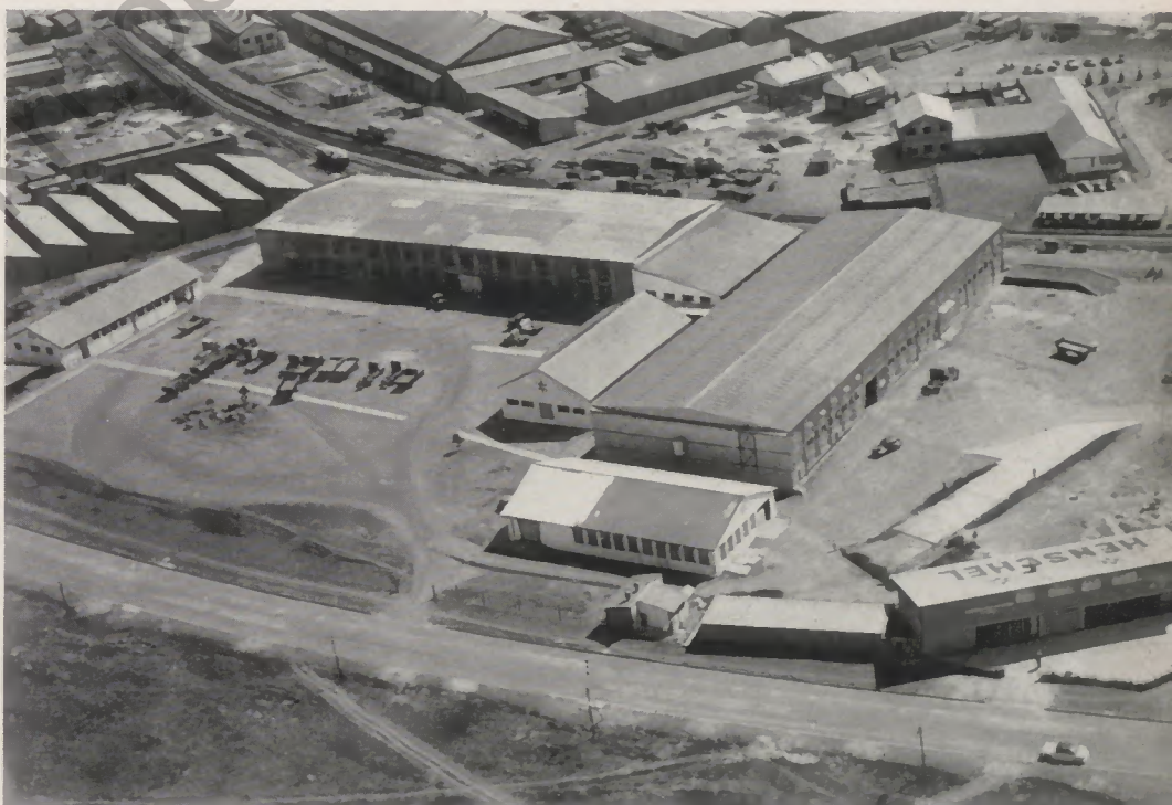
Das Montage- und Reparaturwerk der Henschel (Diesel Truck) (Pty) Ltd. in Wadeville bei Johannesburg, S.A.U.
