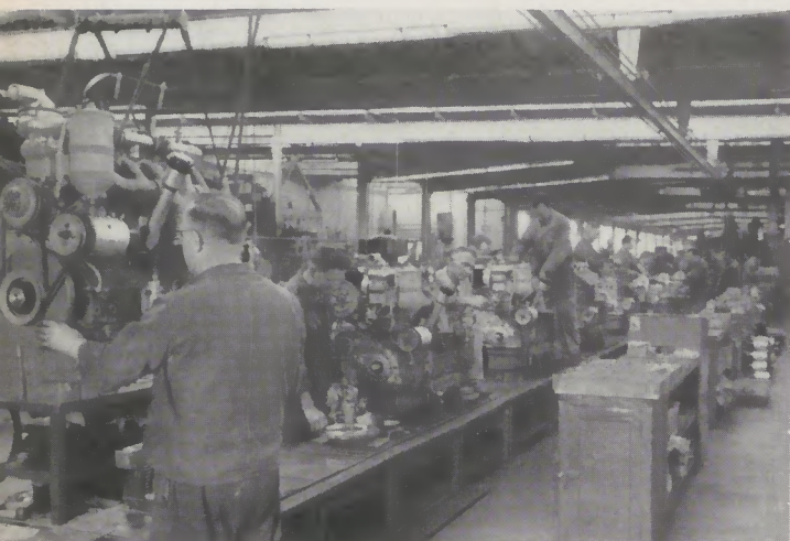
Eine Montagestraße im Henschel-Motorenbau. Henschel Dieselmotoren für alle Einbauzwecke werden am Band gefertigt.
