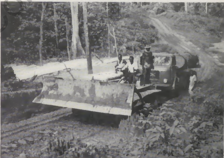
Nach Tropenregen sind die Straßen in dem Urwald bei Libreville nicht mehr befahrbar. Das Bild zeigt einen beladenen Henschel HS 115 mit vorgespanntem Räumer zum Planieren der Straße
