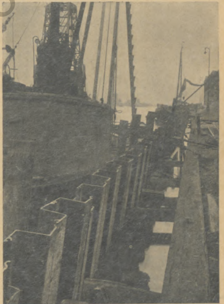
Ufermauer in Dordrecht (Holland) Binnen-Rathaven aus Spundwandblechen „Hoesch“
