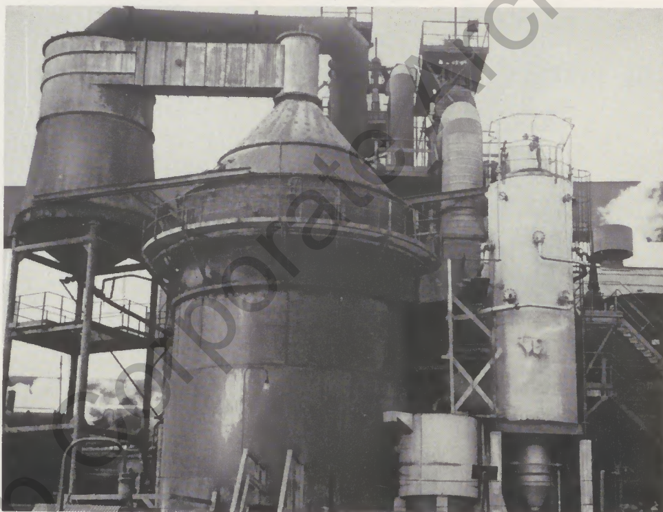
Sprühsättiger (rechts) aus rostfreiem Stahl zum Vergleich mit einem herkömmlichen Tauchrohrsättiger (links) für gleichen Gasdurchsatz
