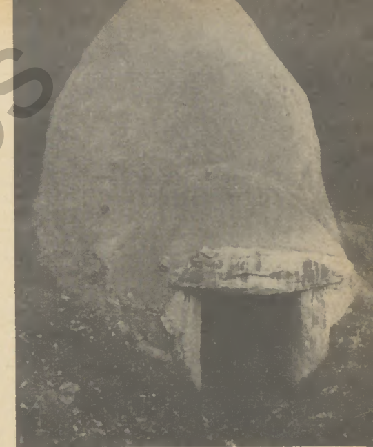
Freistehender Gebläseofen (rekonstruiert) bei Freudenberg im Siegerland
