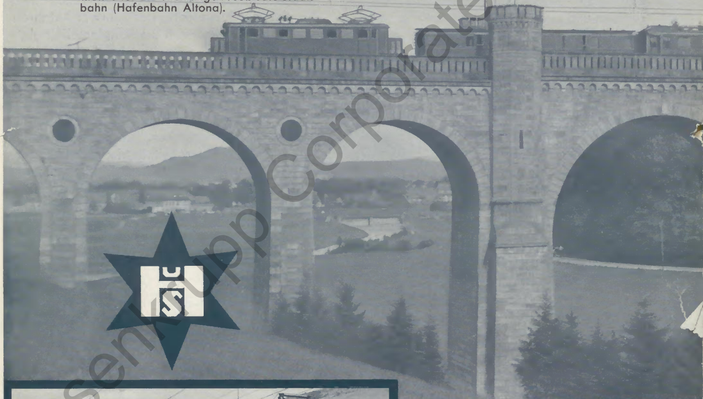
Unten: 1913. Regelspurige Henschel-Bo-Bo-Elekt.-Lokomotive für die ehemalige Preußische Staatsbahn (Hafenbahn Altona).
