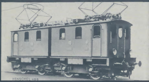
Oben: 1910. Regelspurige Henschel-1C1-Elekt.-Lokomotive für die französische Südbahn.
