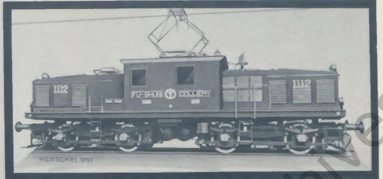
Regelspurige Henschel-Bo-Bo-Elekt.-Lokomotive der Japanischen Schieferminen Fu-Shun-Colliery.
