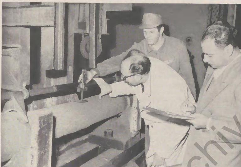
Der Abnahmebeamte der gyptischen Staatsbahnen, Mr. Ibrahim, prft die Verbiegung der Achse. Im Hintergrund Herr Humburg, rechts der gyptische Abnahmebeamte fr die elektrische Ausrstung der Lokomotive, Mr. Baghat.
