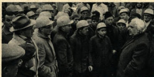
▲ Das Richtfest fällt aus! Am Vorabend des 13. Dezember 1963 ist der große Förderer der Ruhrfestspiele und Ehrenbürger der Stadt Recklinghausen Professor Dr. Theodor Heuss verstorben. Otto Burrmeister (rechts) dankt den Bauarbeitern dafür, daß sie den für das Richtfest vorgesehenen Betrag der „Elly-Heuss-Knapp-Stiftung“ zur Verfügung stellen
