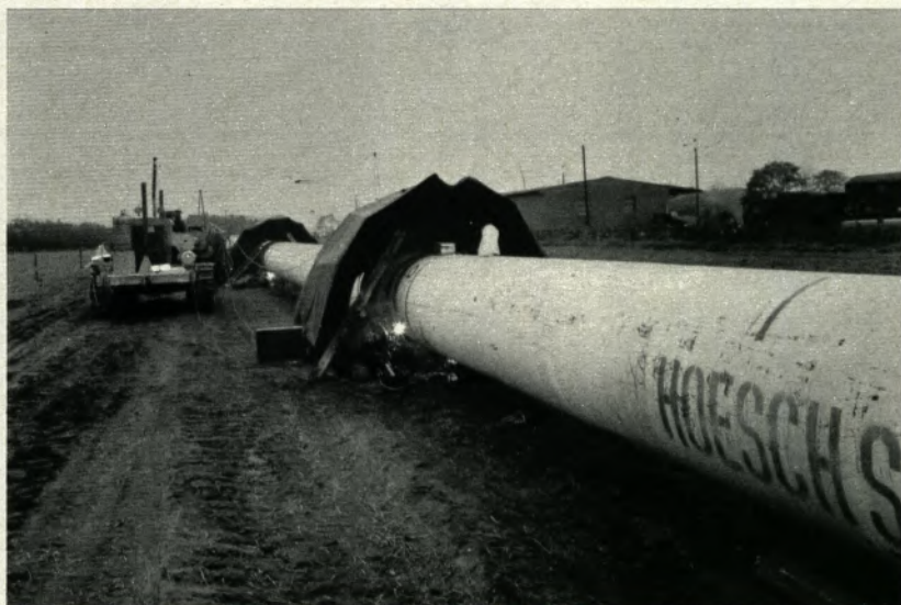
Unter den „Zelten“ ▶ werden die Einzelrohre zur Leitung verschweißt
