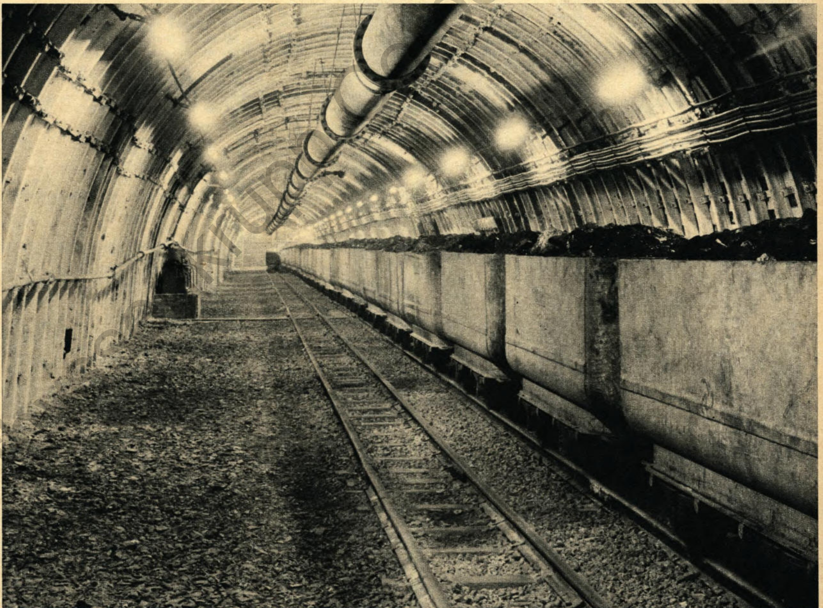
▲ Dieser Blick auf das Füllort und auf den zur Förderung bereitstehenden Kohlenzug auf der 8. Sohle im Hansenschacht zeigt die menschenleeren, weitläufigen Gleisanlagen des Füllorts
