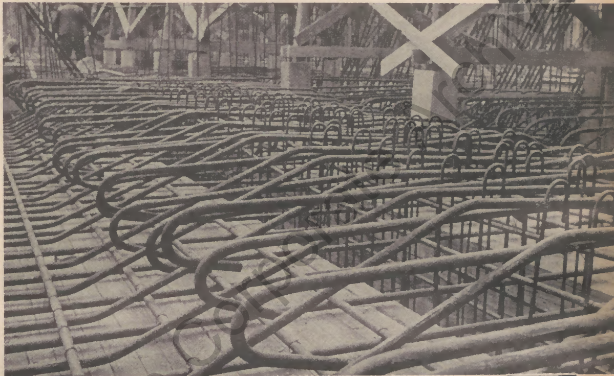
Armierung mit Betonstahl II
