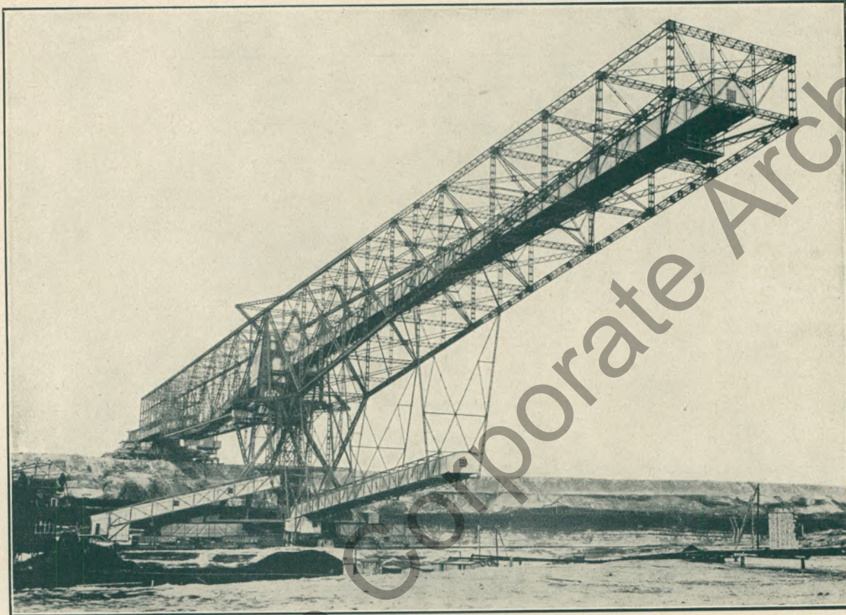
Eine 400 Meter lange Förderbrücke auf der Braunkohlengrube Golpa der Reichs-Elektrowerke.
