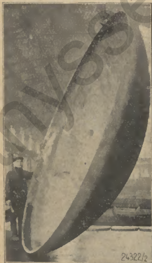
Tiefgewölbter Behälterboden aus einem Stück gepreßt beim Stahl- und Walzwerk Thyssen
