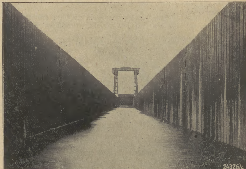
Schleuse Hünre des neuen Lippe-Seitenkanals, die größte Stahlschleuse der Erde, hergestellt aus Spundwandisen „Larssen“ der Dortm. Union
