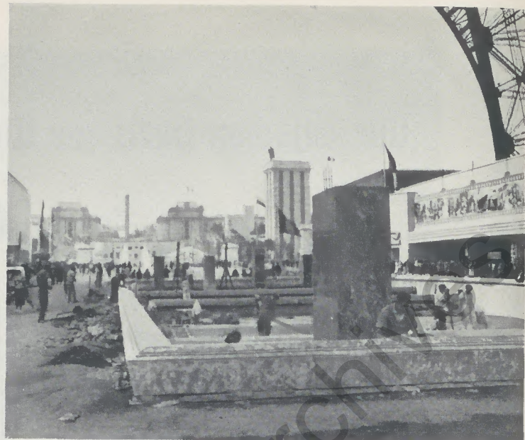
Überall wird noch gebaut
