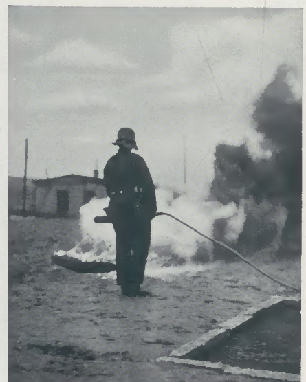
Ablöschen eines Ölbrandes mit Kohlen-säureschnee-Gerät
