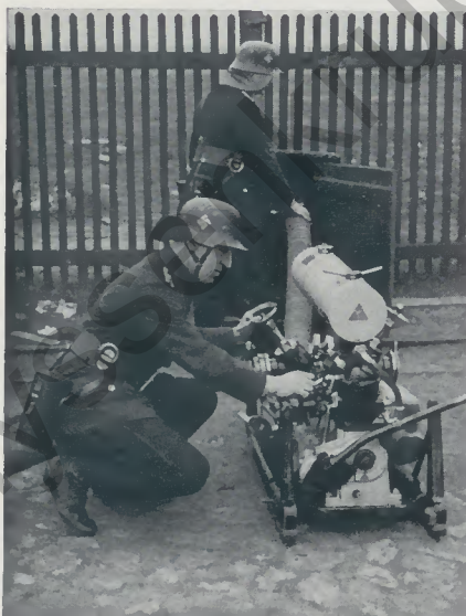
Arbeiten mit der Kleinmotorspritze vom Feuerlöschbrunnen
