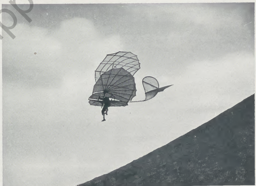
Ein Doppeldecker im Flug. Bemerkenswert das Leitwerk, das zusammen mit dem frei beweglichen Körper den Apparat im Gleichgewicht hält
