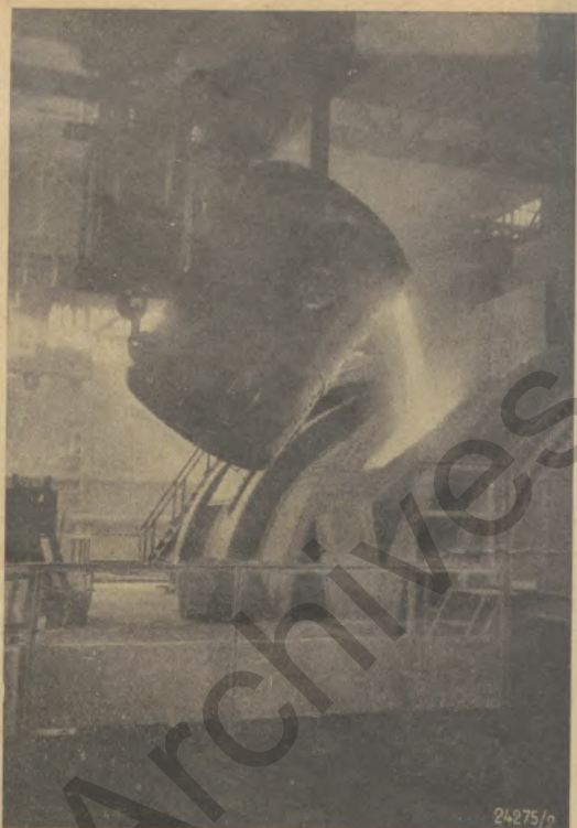
Eingießen von Roheisen in einen Mischer
