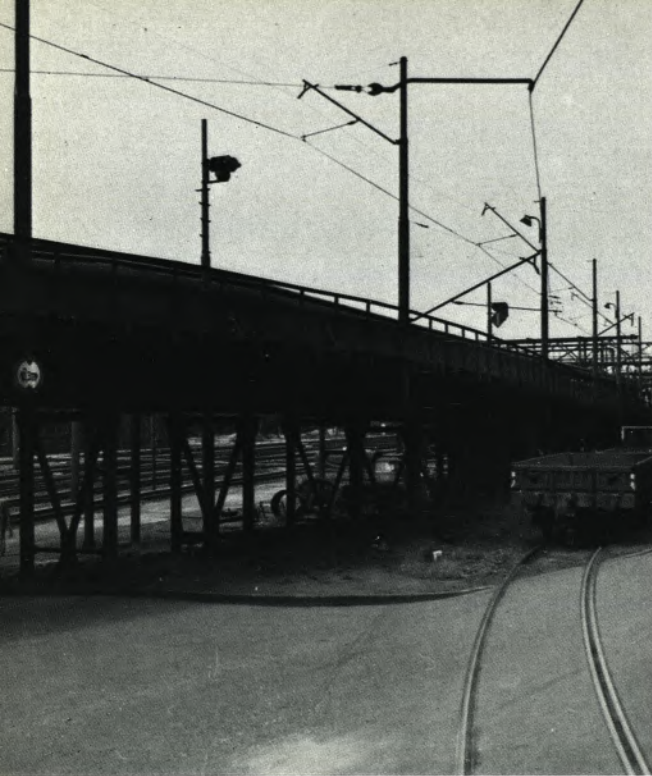
Die alte Pfeilerbahn vor Beginn der Bauarbeiten
