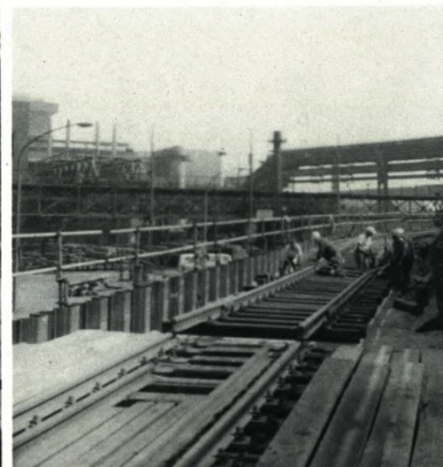
Ein Gleisjoch schließt wieder die vorhandene Lücke
