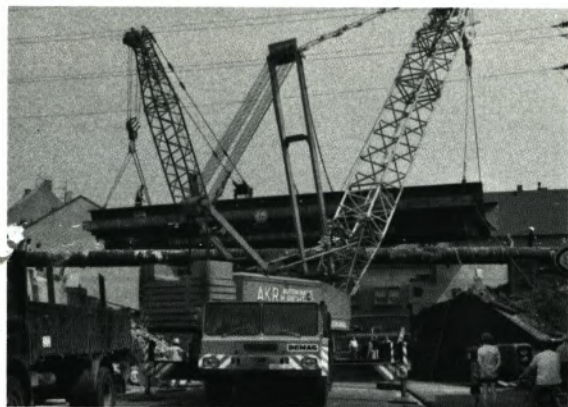
Am 10. August wurde der Stahlüberbau für die Werksbahnbrücke Neumühler Straße in Oberhausen-Sterkrade eingebaut.
