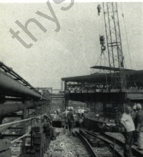
Eine Gleisbrücke wird mit dem Autokran demontiert
