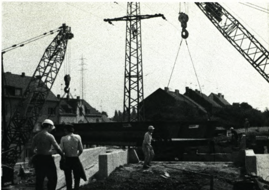
Am 10. August wurde der Stahlüberbau für die Werksbahnbrücke Neumühler Straße in Oberhausen-Sterkrade eingebaut.
