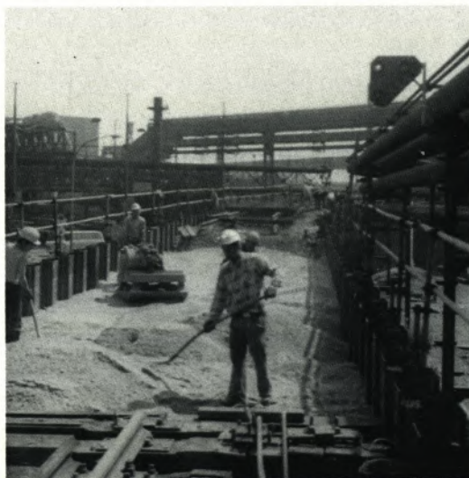
Nach der Demontage einer Gleisbrücke wird der noch fehlende Kies mit Kübeln eingebracht, verteilt und mit einem Rüttler verdichtet
