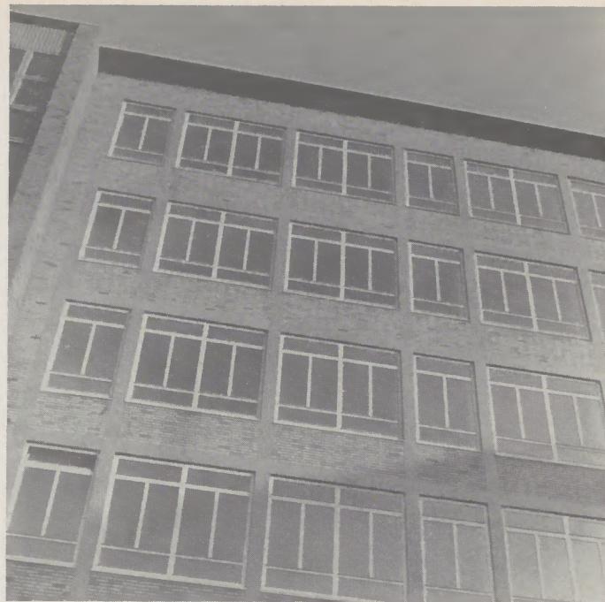
Blick auf die Außenfront: deutlich erkennbar der mit Glasmosaik kleidete Betonrahmen und die mit Klinkersteinen verblendeten Gefache.
