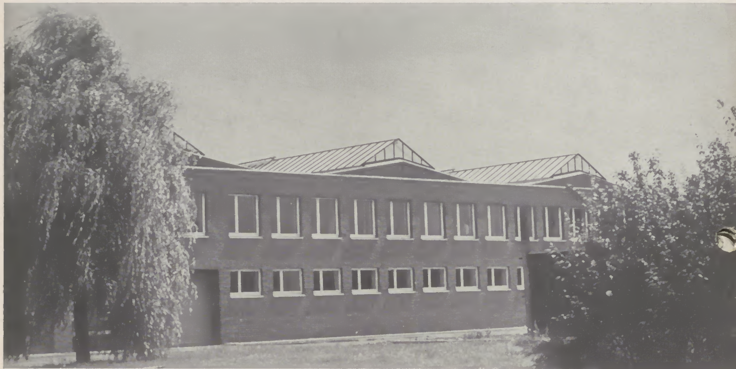
Unser Dortmunder Mitarbeiter Dr. phil. Werner Hotop hat in einer umfassenden Arbeit mit reichem Bildmaterial das Werden und die Schicksale der Abteilung Sintermetall-Fertigung der Magnetfabrik Dortmund in den ersten zehn Jahren ihres Bestehens festgehalten. Der nachfolgende Artikel bringt Auszüge aus dieser größeren Arbeit.
