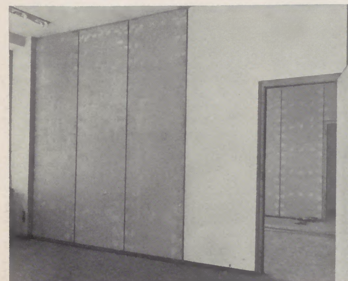
Unser Bild zeigt die Zwischenwände, die beliebig versetzt werden können. Die linke Seite noch im Rohbau, die rechte Seite so, wie sie nach der Fertigstellung aussehen wird.
