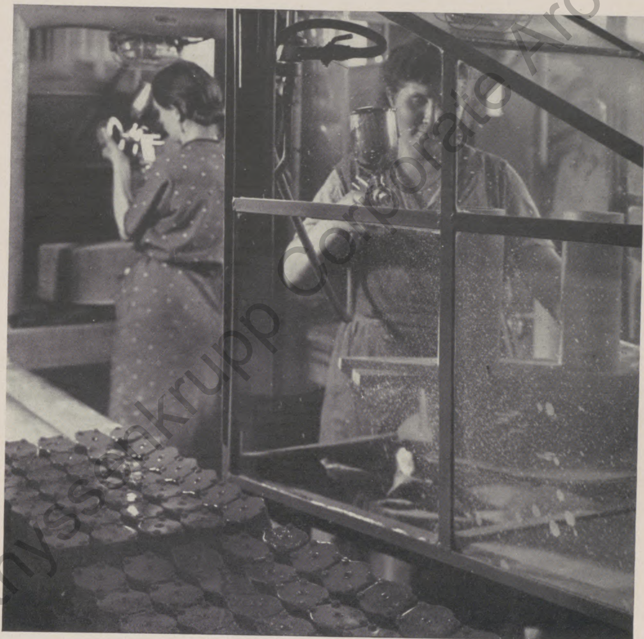
Frauen im Werk. Spritzlackieren von Oerstit-Magnetssystemen für Lautsprecher, Werk Dortmund.
