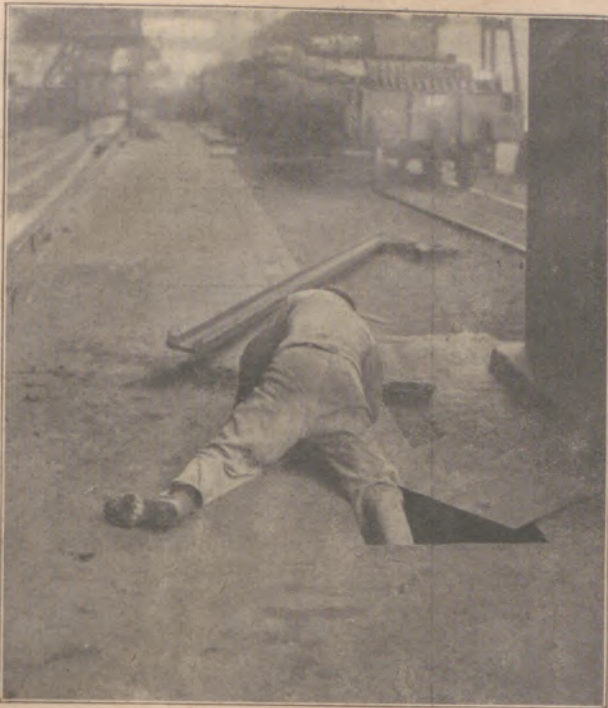
Ein Mann stürzt in eine Oeffnung, die leichtsinnigerweise nach einer Reparatur nicht geschlossen wurde
