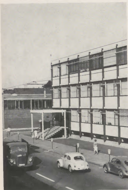
Rückseite: Stahl bestimmt das Gesicht des neuen Verwaltungsgebäudes der Dörken AG, bei dessen Bau die von Hoesch entwickelten Bauelemente, wie das Tektal-Dach, die Bandstahldecke und Wandelemente aus dem Stahlfertighaus-Programm, verwendet wurden
