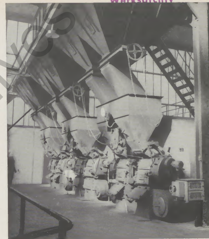
Die neue Ofenanlage
