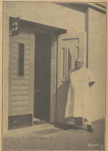
Eingang zum Unfallraum des Stahlwerks Krieger mit unserm „Dicken“
