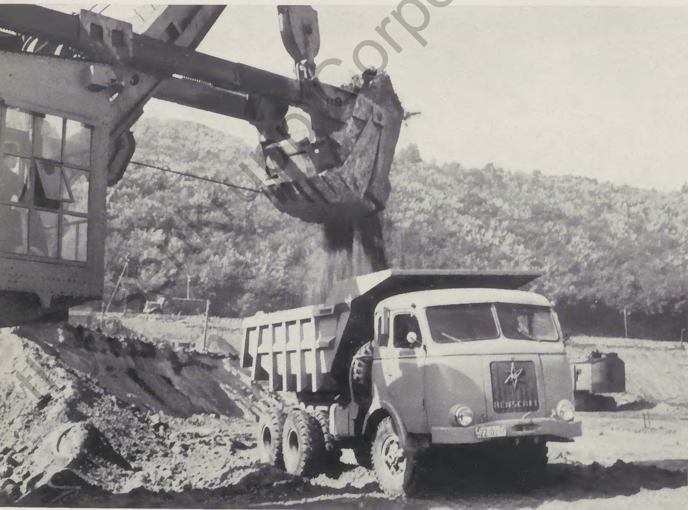
Einsatz des Mulden-Kippers bei Erdbewegungen auf Großbaustellen
