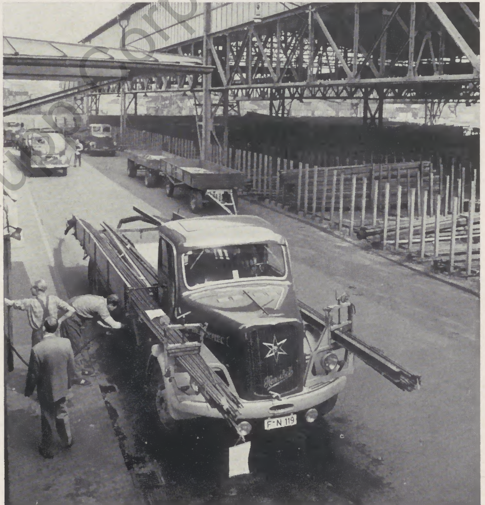
Langeisen-Transportwagen mit seitlicher Durchladung und vorderer Auflegestütze
