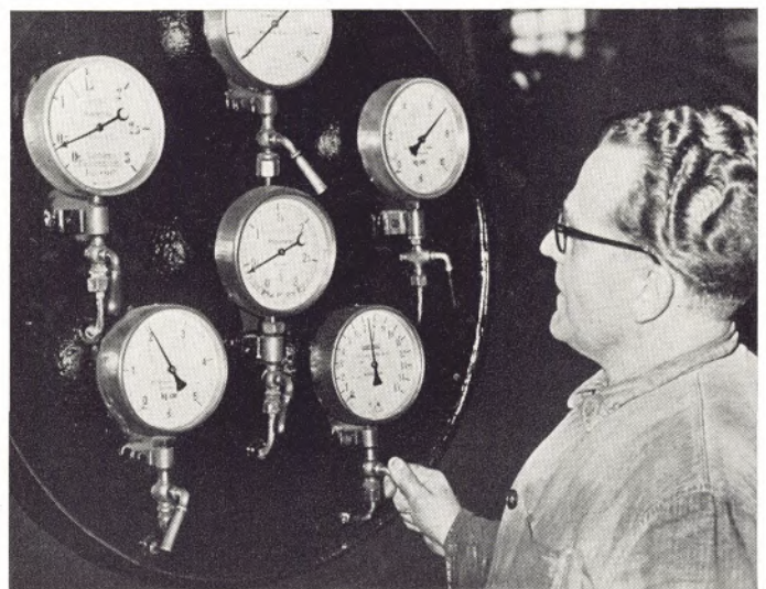
Maschinist Wilhelm Meuthen, auch schon „alter Hase“ auf der Hütte, am Kontrollstand für die Kompressoren in unseren Kraftanlagen
