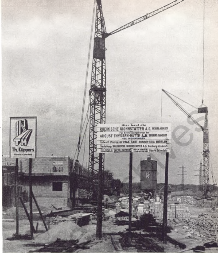
Mit dem Bau der Mietwohnungen am Röttgersbach wurde begonnen
