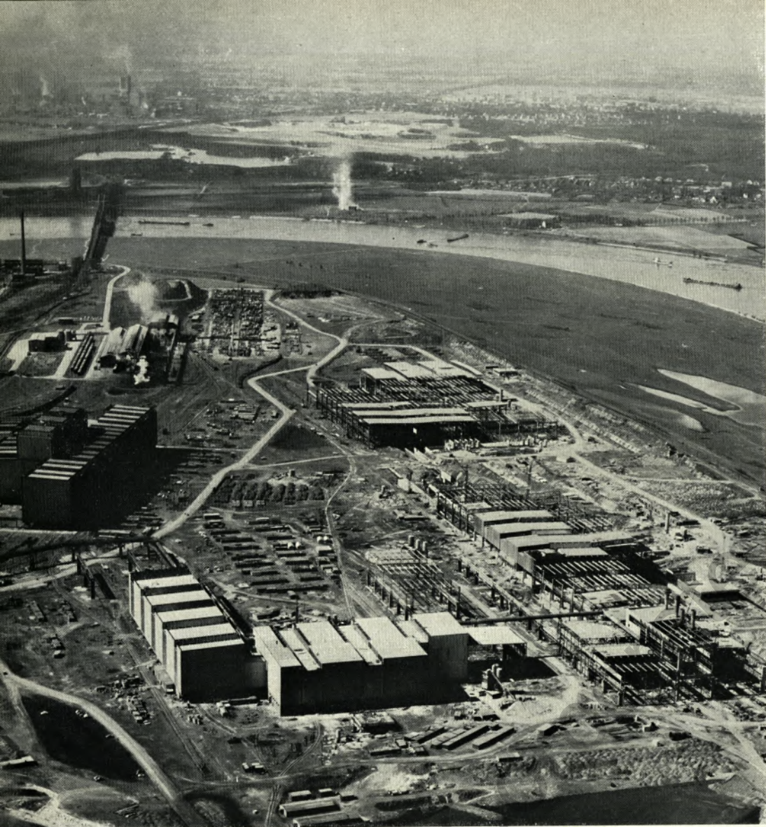
Die Weiträumigkeit der Anlagen läßt die Luftbildaufnahme erkennen.
