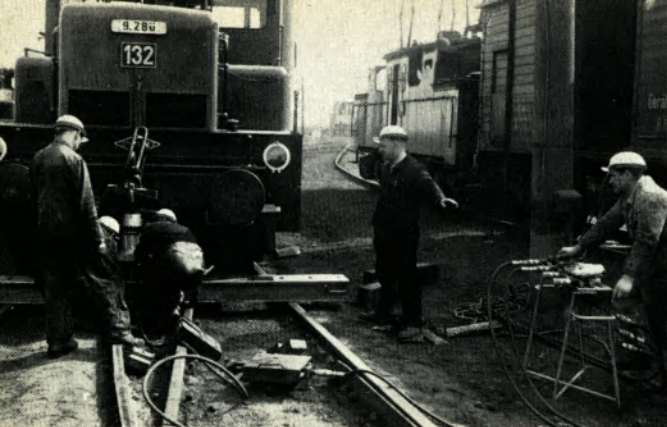
Die entgleiste Lok mit dem Gerätewagen des Abschnittes Süd (rechts im Bild) und der Aufgleismannschaft unter Leitung des Lokführers Janiki.
