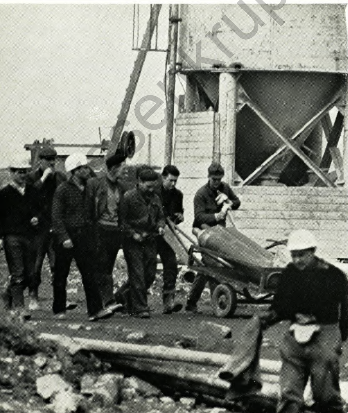
Schichtanfang, ein gewohntes Bild an der Baustelle.
