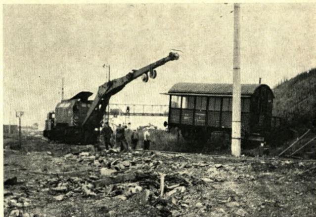
Das Behelmsstellwerk Hagen Schwegeln Nord mußte den Bauarbeiten weichen. Der 24-t-Diesekran beim Versetzen.
