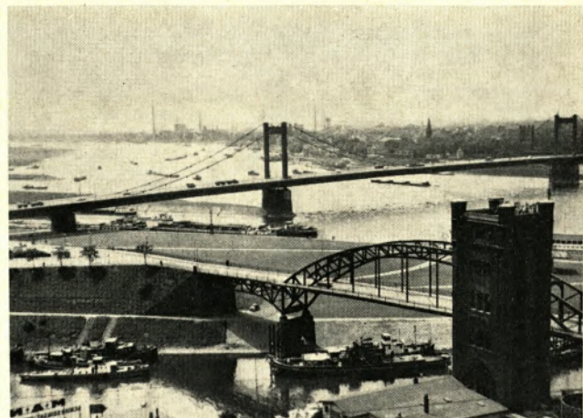
Ein Blick vom Hochdruckkraftwerk der PHX auf den Rhein und die Homberger Brücke.
