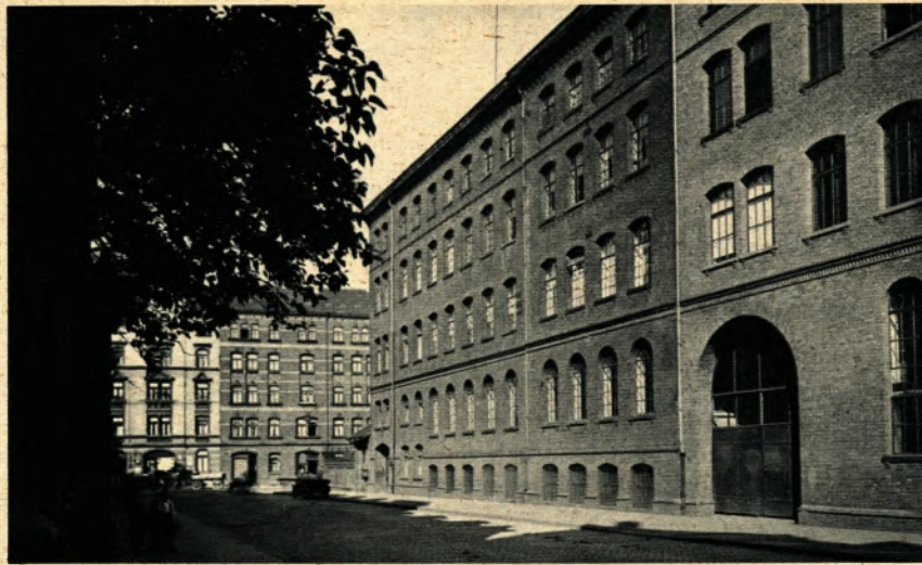
So sah bis zum zweiten Weltkrieg das Fabrik- und Verwaltungsgebäude von Federstahl Kassel aus
