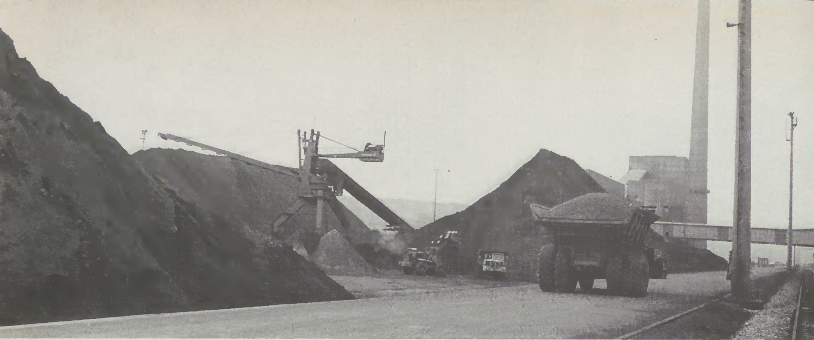
Erzlagerplatz: Absetzer, Aufladegerät („Trojan“) und Großmuldenlastwagen (Bildmitte)
