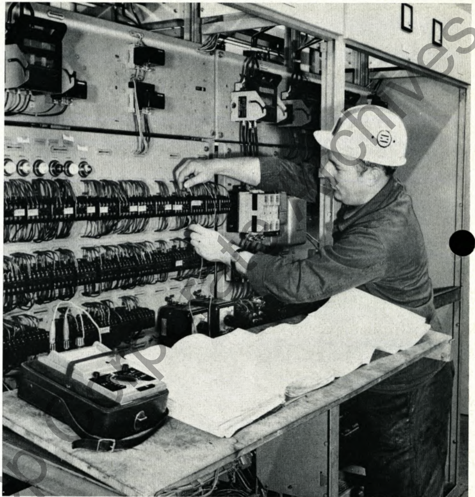
Betriebselektriker bei der Arbeit in der Rohrkontistraße. (Aufnahme Nr. 1)
