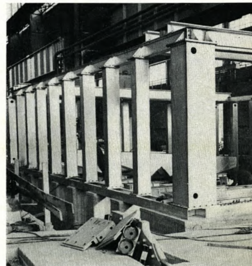
Unsere Aufnahme zeigt den neuen Ofen, der im Werk Poensgen zum Härten, Normalisieren und Anlassen von Güterohren unseres Pilgerwalzwerkes errichtet wird, im Bau. 4
