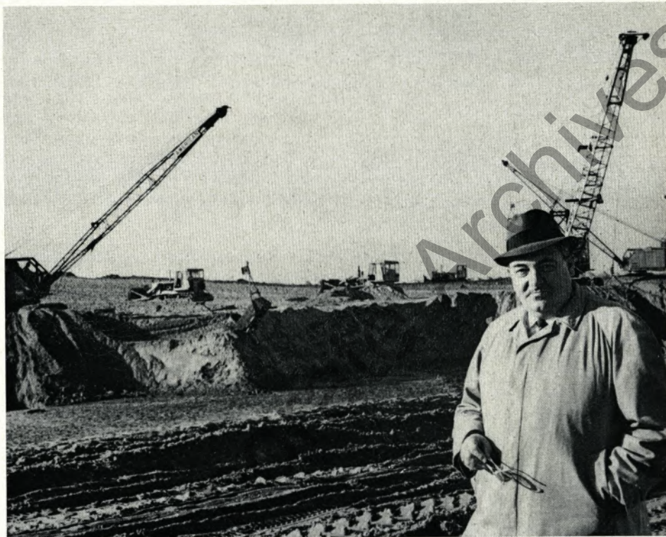
Unsere Aufnahme zeigt Dipl.-Bergingenieur Karl Heinz Zepter, der mit der Leitung des Baues der neuen Erzumschlaganlage im Rotterdamer Hafengebiet Europoort beauftragt wurde, nach einer Besichtigung der ersten Erdarbeiten, die in großem Umfange notwendig sind.
