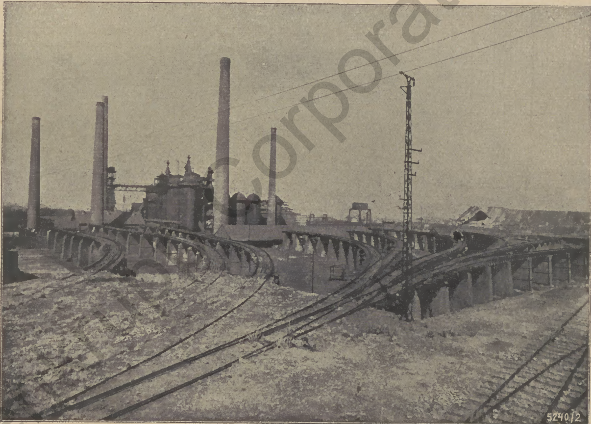
Der Abbruch der Bergeborbecker Hochofen der Phönix A.-G. durch die Dortmd. Union
