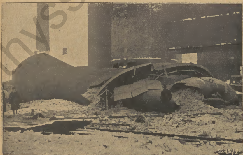
Die Trümmer eines gesprengten Cowpers
