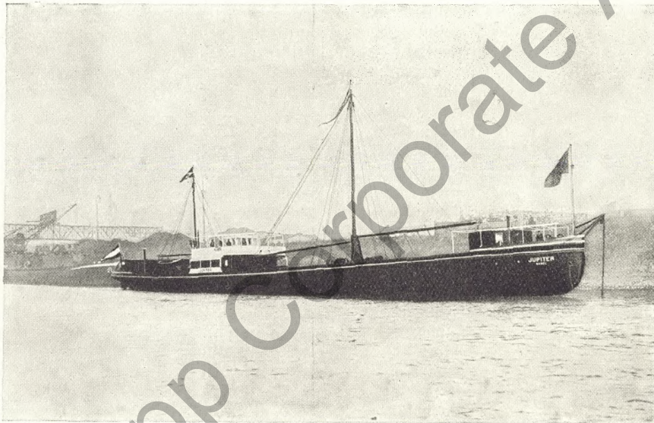
Dieselmotor-Güterboot „Jupiter“ in unbeladenem Zustande Das Schiff ist erbaut von der Rheinwerft Walsum der Gutehoffnungshütte, trägt bei 2,30 m Tiefgang 722 Tonnen einschließlich 30 Tonnen Del (Brennstoff)
