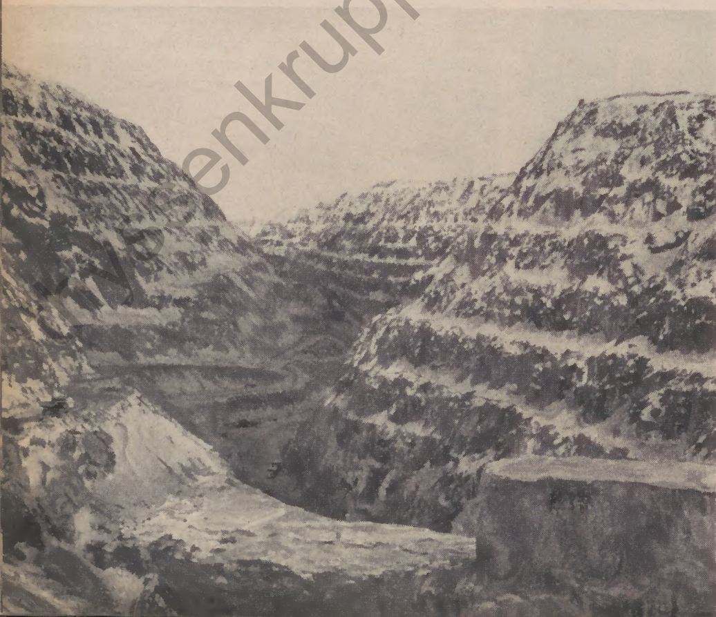
Übertagebau in Kiruna. Terrassenförmig wird das Erz abgetragen
