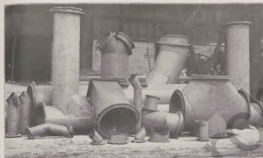
Abb. 5: Autogen geschweißte Rohre, Form- und Paßstücke für den Umbau eines Stohofens
