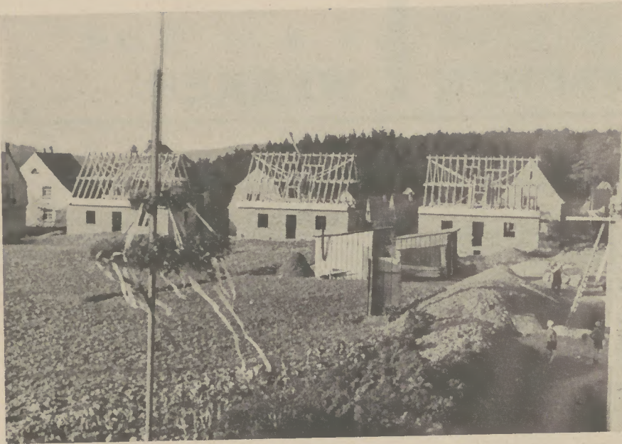
Ein Blick auf die neue Werksiedlung in Herdringen. Elf neue Häuser entstehen hier auf dem Krähenbrink.
