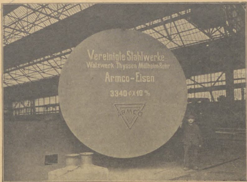
Größter bisher in Deutschland hergestellter Kesselboden aus Armco-Eisen
